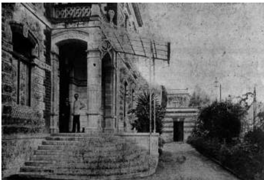
Vistas exteriores de la casa de la legación belga en la calle de Industria. Semanario El Mundo Ilustrado , 8 de septiembre de 1901.
