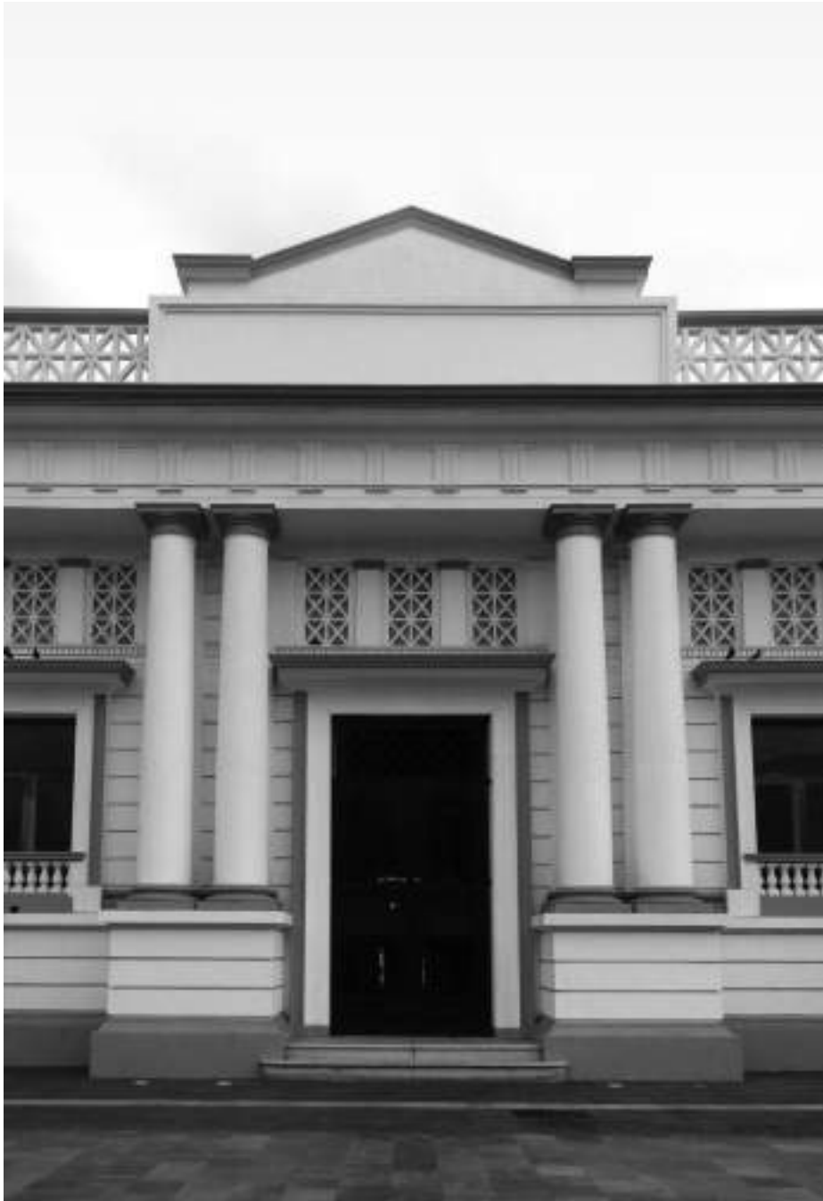
Cuerpo central del edificio de la Aduana Marítima. Fotografía: ISM, diciembre de 2013.
