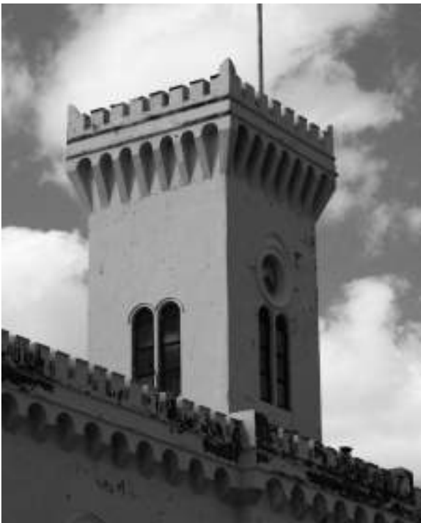
Vistas de la antigua Penitenciaría de Mérida. Fotografías: ISM, noviembre de 2013.
