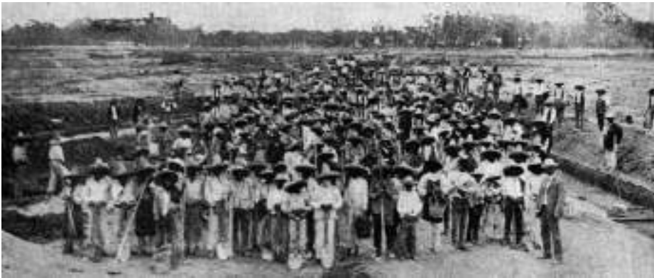
Albañiles en los trabajos de cimentación del nuevo coso taurino. Semanao El Mundo Ilustrado , 24 de junio de 1906.
