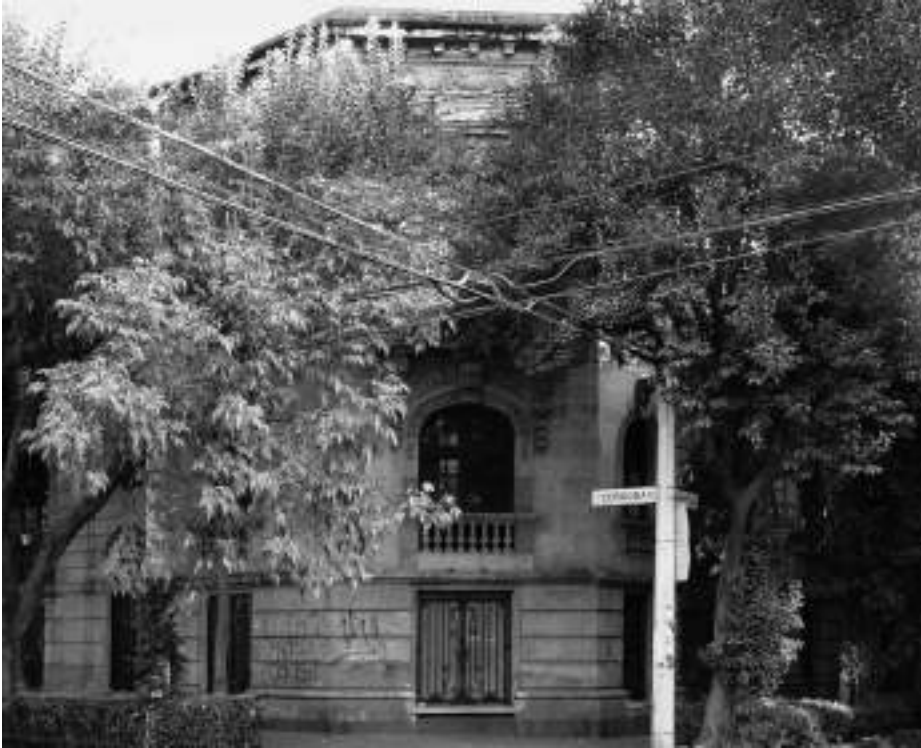
Edificio de departamentos en la calle de Tabasco núm. 133, esquina con Córdoba, en la colonia Roma. Fotografía: ISM, octubre de 2010.
