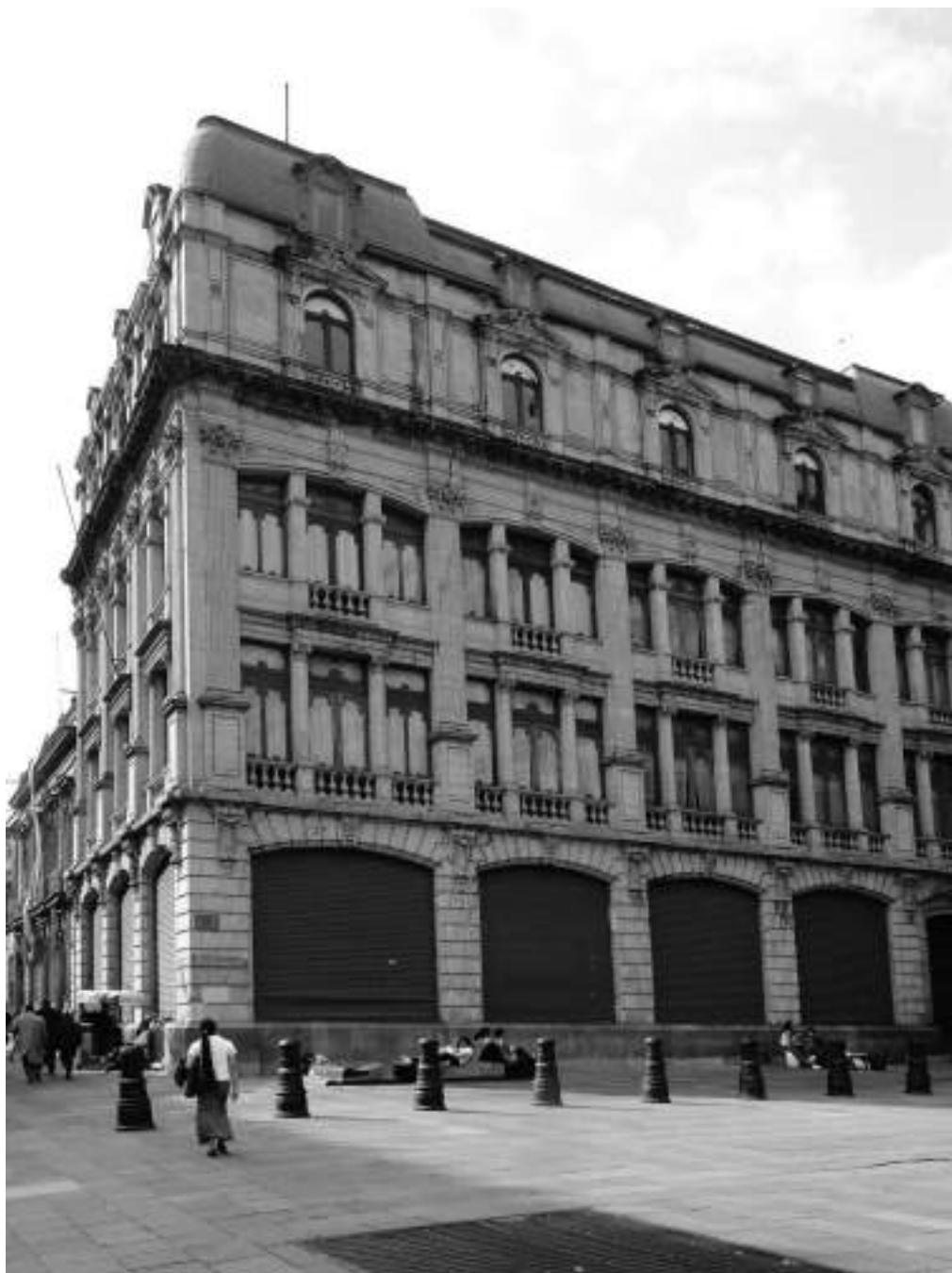
Edificio Garantías en la calle de Marconi y Tacuba, en el Centro Histórico. Fotografía: ISM, octubre de 2010.
