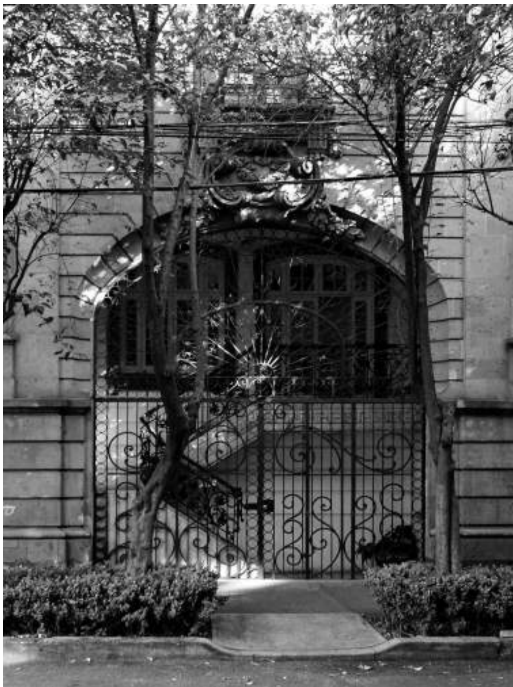
Edificio de departamentos en la calle de Tabasco núm. 133, esquina con Córdoba, en la colonia Roma. Fotografías: ism, octubre de 2010.
