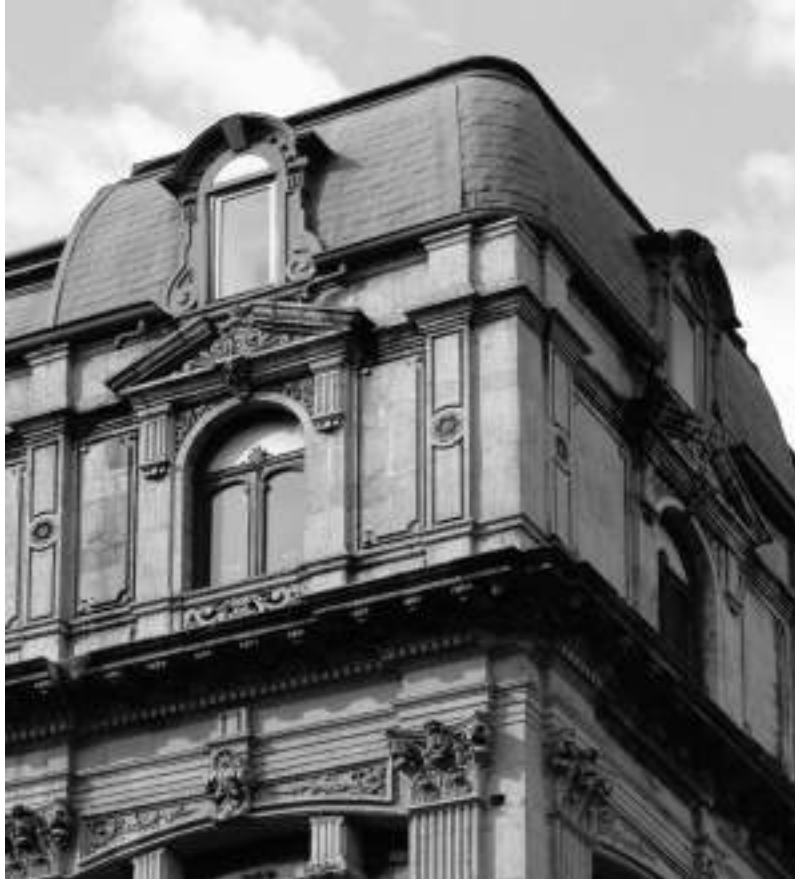
Remate en el último nivel del edificio Garantías, en el Centro Histórico. Fotografía: ism, octubre de 2010.
