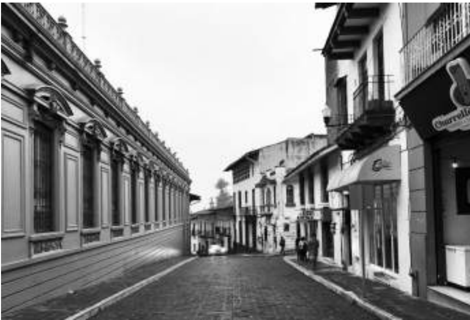
Vistas recientes de la fachada lateral del Colegio Preparatorio de Xalapa, Veracruz. Fotografías: Nairobi Díaz Ordaz (NDO), mayo de 2017.
