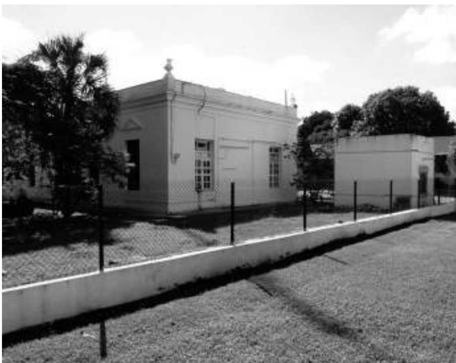
Arriba, imagen del Hospital O'Horán como apareció publicado en 1910 en el libro México en el Centenario de su Independencia (México, SIP, 2009, lám. 346). Abajo, vista reciente de los pabellones que aún existen; fotografía: ISM, noviembre de 2013.
