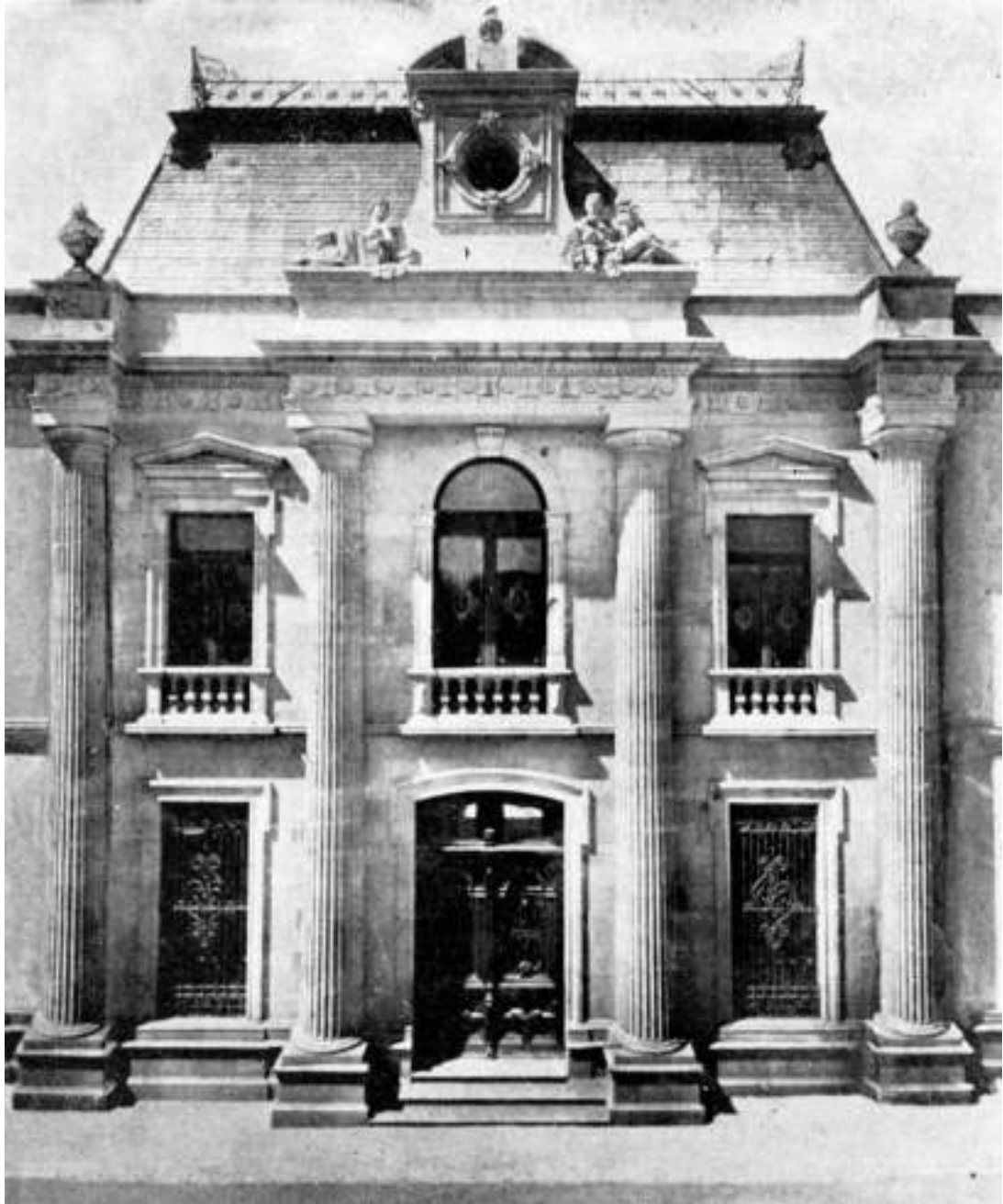
Fachada oriente del Instituto de Ciencias y Artes de Oaxaca intervenida por el ingeniero militar Rodolfo Franco. Izquierda, México en el Centenario de su Independencia (México, ssp, 2009, lám. 312); derecha, El Mundo Ilustrado , 12 de julio de 1908.
