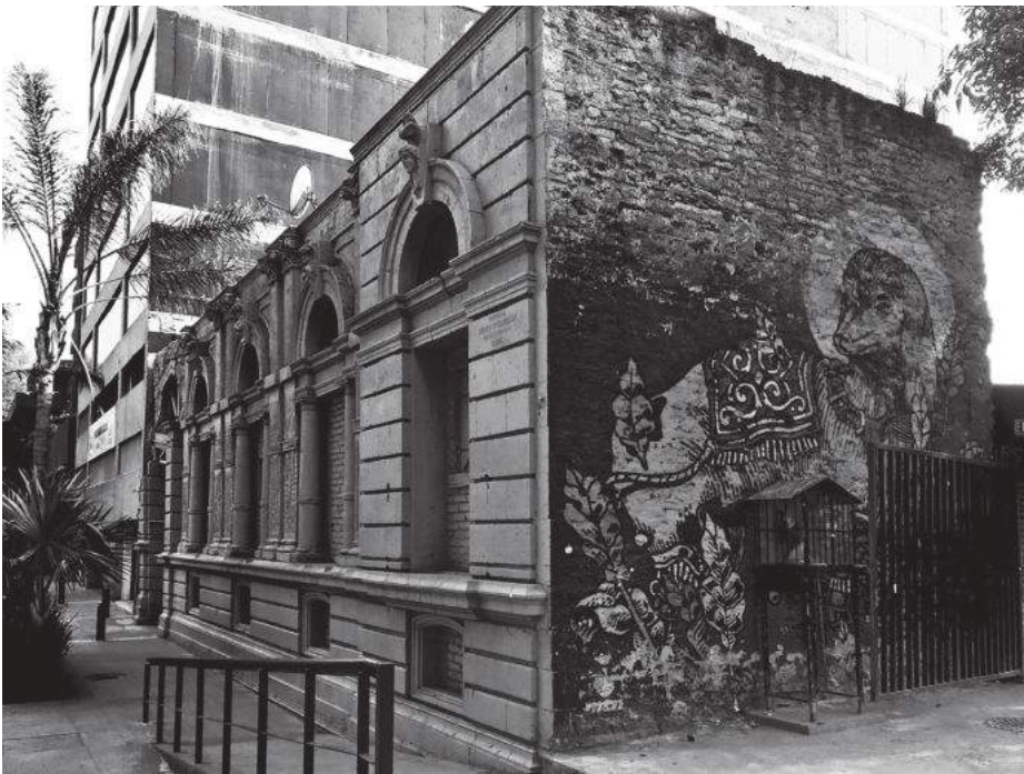
Arriba, imagen de la casona en la calle de Jalapa núm. 13, en 2005. Abajo, imagen reciente (abril de 2017). Fotografías: ism.
