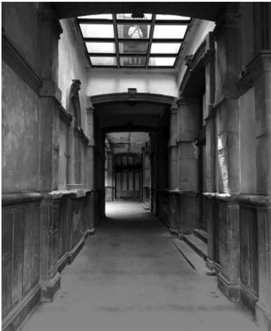
Vista desde la calle del pasaje que comunica con el patio principal. Fotografía: ISM, febrero de 2019.
