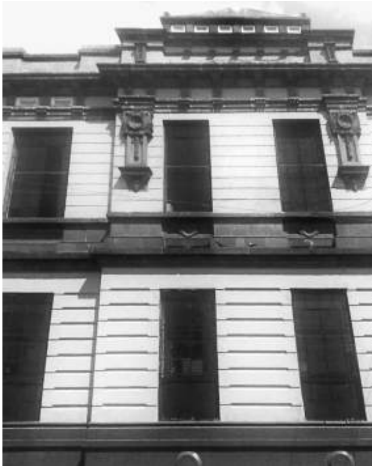
Vista del conjunto escolar, en la zona de la escuela primaria "Josefa Ortiz de Domínguez". Fotografías cv, mayo de 2019.
